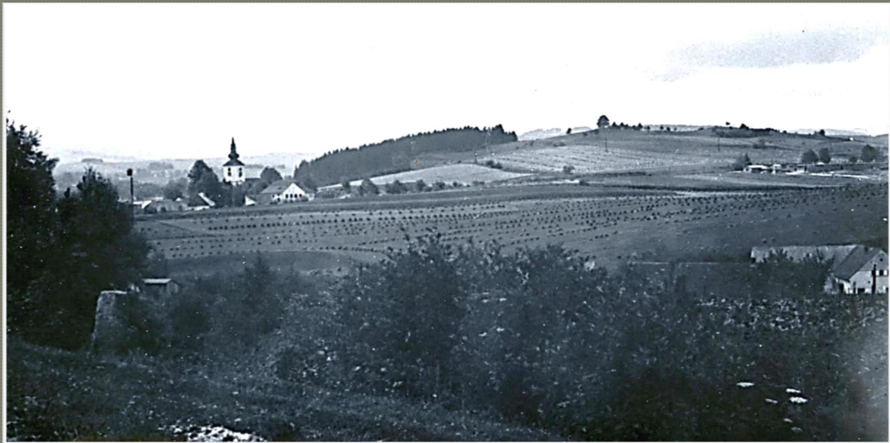
1957 • Pohled západním směrem. V r. 1957 proběhla v Kolinci kolektivizace zemědělství. Na snímku vpravo je vidět rozestavěný kravín. 149
