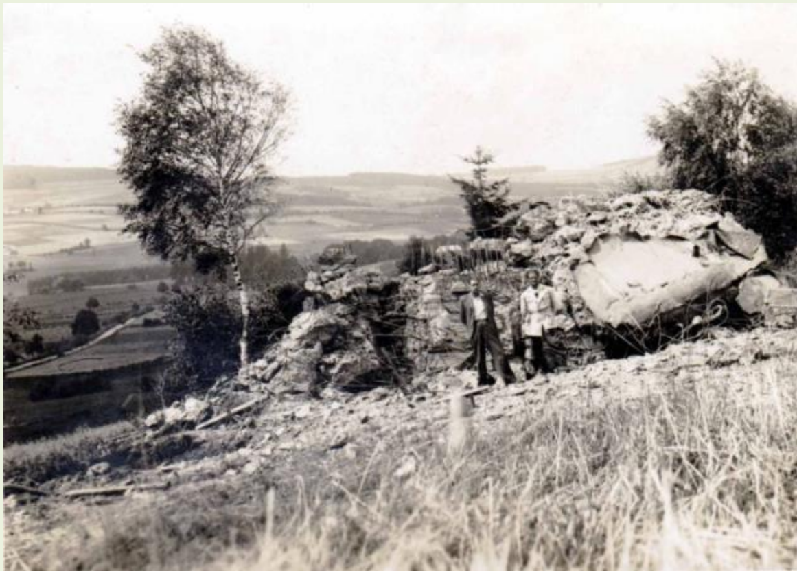
Zničený řopík pod “Šibeničním vrchem“ u Velhartic – r. 1941
