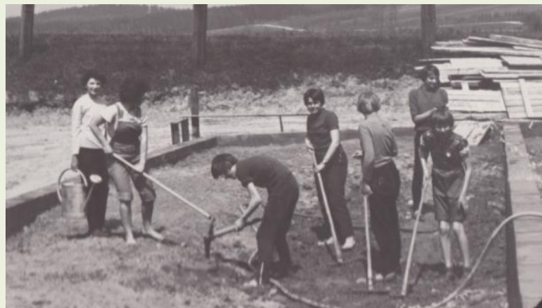
R. 1967 zahájení stavby školního pavilonu
