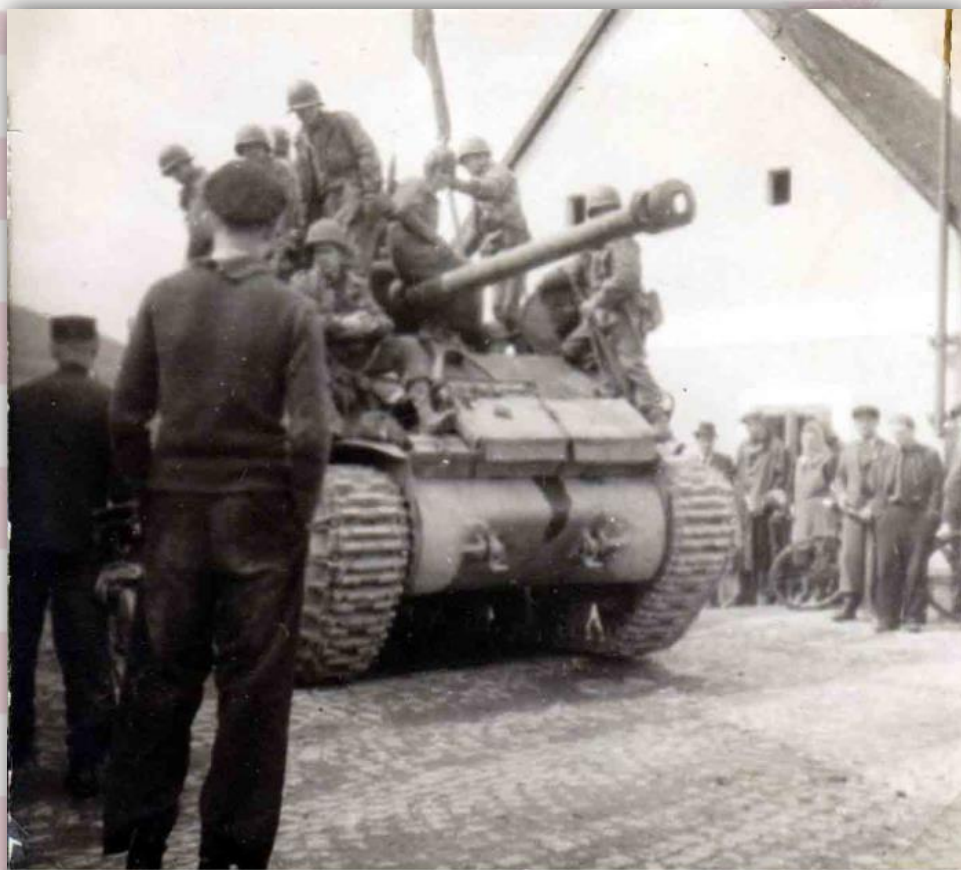
7.5.1945. Před domem čp. 45. Vjezd do ulice od kampeličky k nádražní ulici. Foto archiv Fr. Mára.
